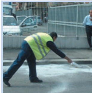
BONIFICA CON LA CREAZIONE DI UN PICCOLO CANTIERE
